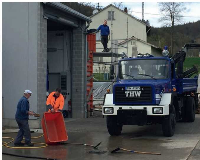
Aus der OV-Geschichte: Reinhold Brunn im Jahr 2016 bei den Bauarbeiten zur Garage (links im Bild, rechts daneben sein Sohn Christian Brunn)
