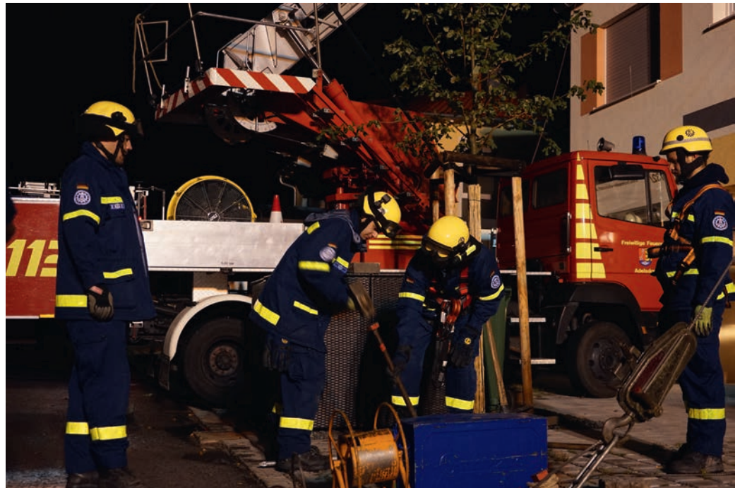
Baiersdorfer Helfer schlugen Erdnägeln in den gepflasterten Boden, um Anschlagpunkte für die Greifzüge zu schaffen, sodass das Dach niedergezurrt werden konnte.
