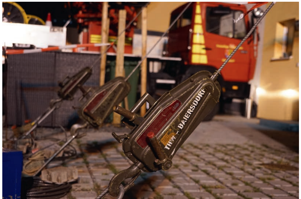
Durch den Einsatz von mehreren Mehrzweckzügen konnte das Pultdach niedergezurrt werden.
