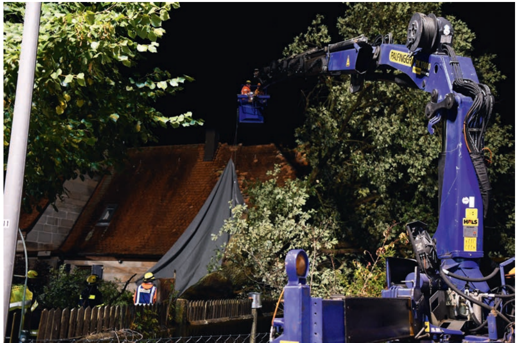
Sicherung des beschädigten Daches mittels Plane durch Zuhilfenahme des Bayersdorfer Unimog-Krans.
