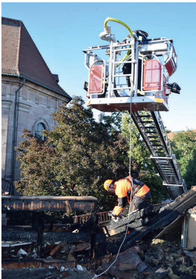
Wir vertrauen uns blind. Ein THW-Helfer wird beim Arbeiten mit der Motorsäge durch einen Feuerwehrkameraden gegen Absturz gesichert.
