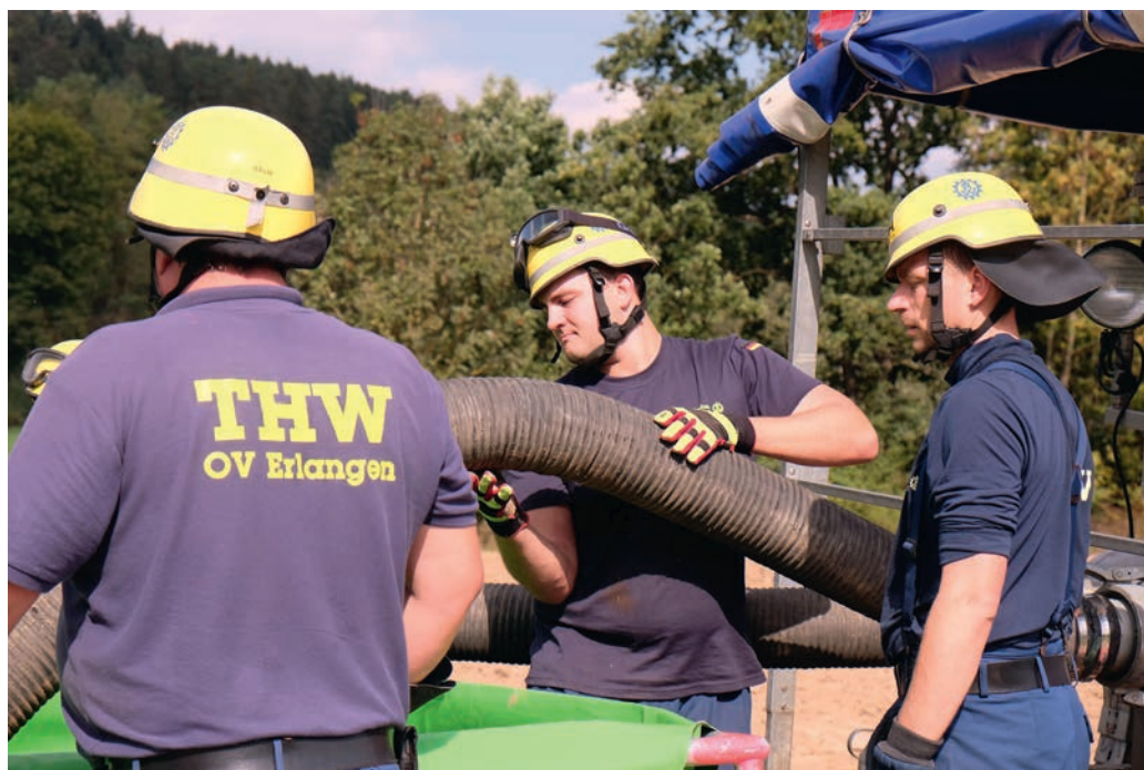
Mittels Faltbehältern erfolgte die Übergabe des geförderten Wassers an die nächsten Pumpe bzw den nächsten Leitungsabschnitt.
